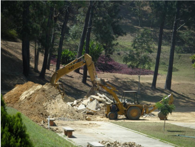
Maquinaria trabajando a las horas de clase en pabellones
